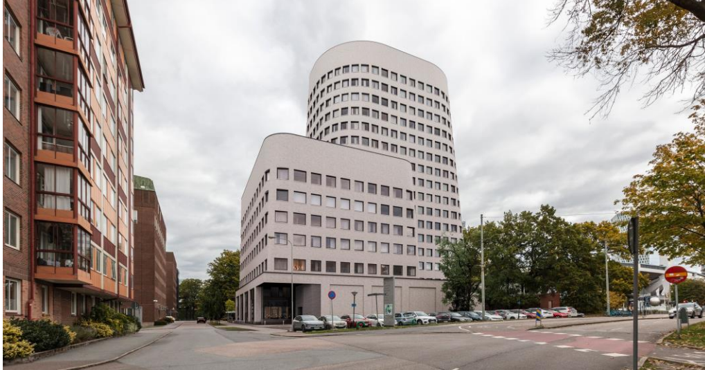
Figur 1: Vy från Bohusgatan mot norr (Wingårdh Arkitektkontor).
